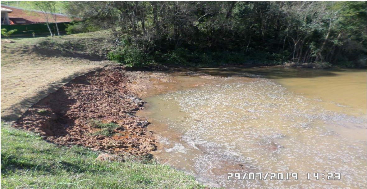
Em agosto, foi deferido o pedido junto à Prefeitura do Município de Itatiba para execução de contenção no trecho brejoso, onde antes havia o montante de terra com a presença de entulho depositado por gestão passada. Adotou-se o método “enrocamento” para conter o maciço de solo.
