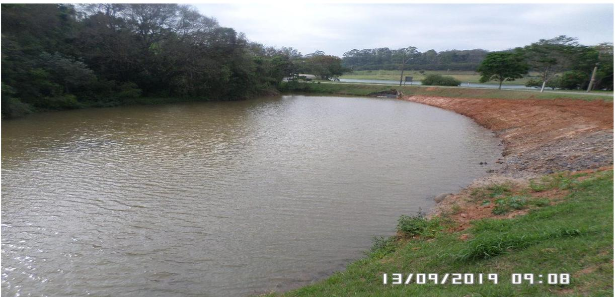
Foi executado uma berma, no lado oposto ao enrocamento, com intuito de conter todo maciço de solo e via pública nas proximidades das áreas desassoreadas. Todo o trecho acabado, berma e talude, foram revestidos com grama, para melhorar o aspecto estético do local e prevenir erosões.
