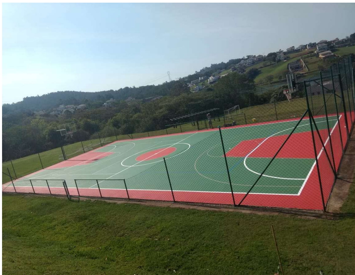
Quadra Poliesportiva - Após a pintura
