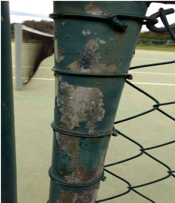
Proteção (tinta) das estruturas danificadas pela ação de intempéries
