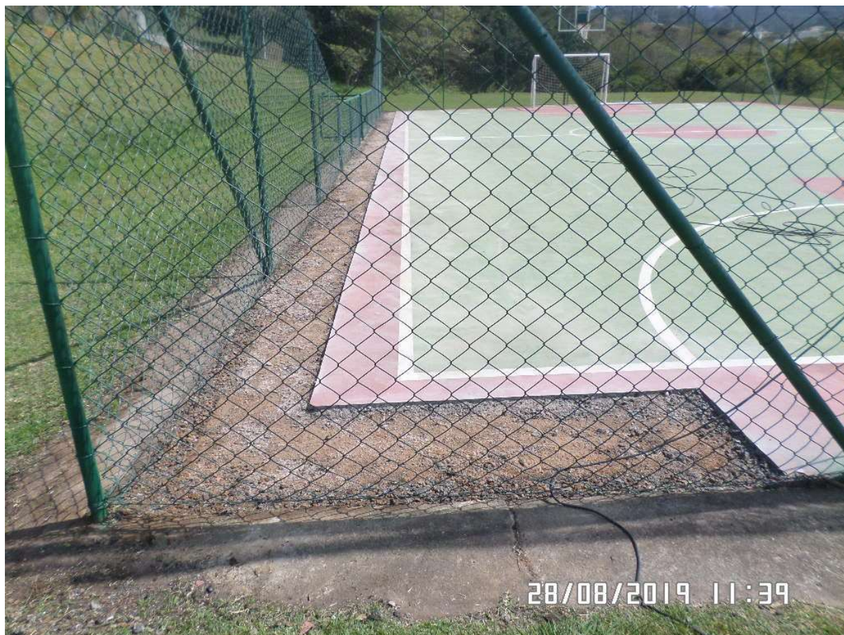
Quadra Poliesportiva - Reparo em trecho danificado
