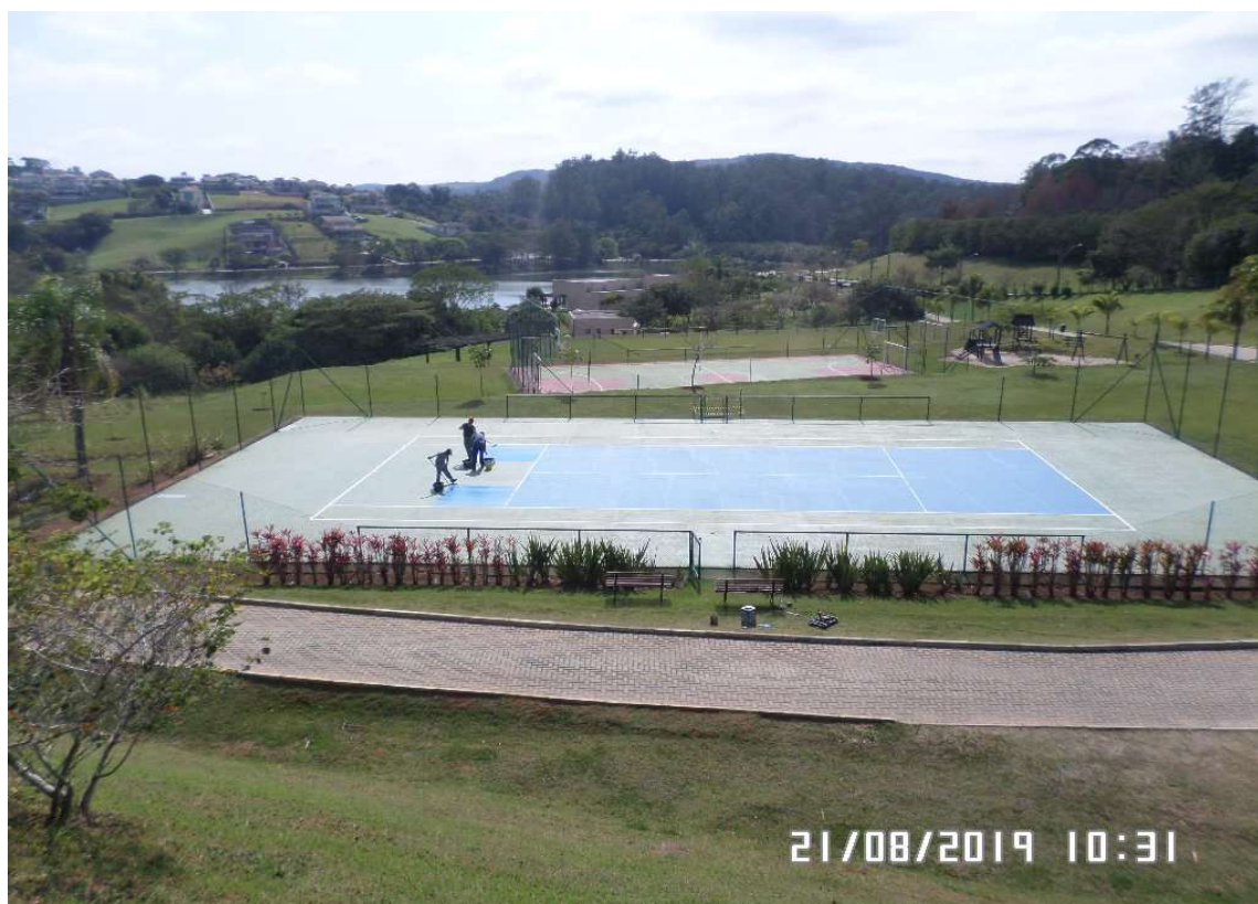
Quadra de Tênis - Durante a pintura
