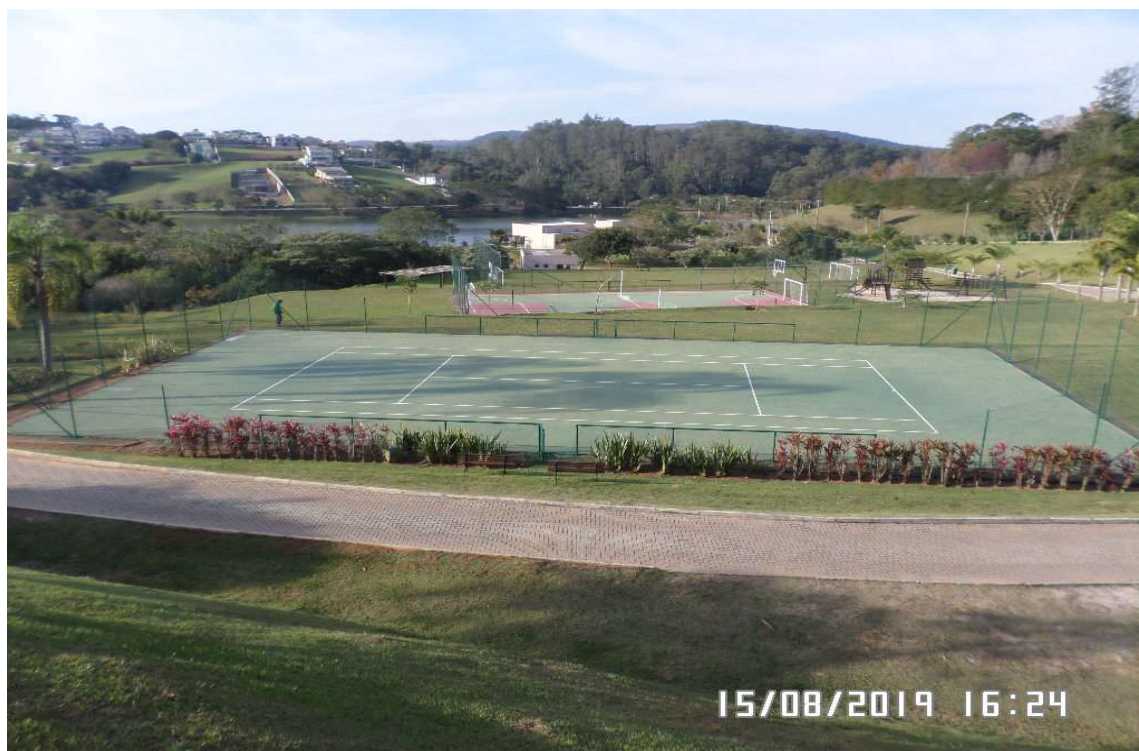
Quadra de Tênis - Antes da pintura
