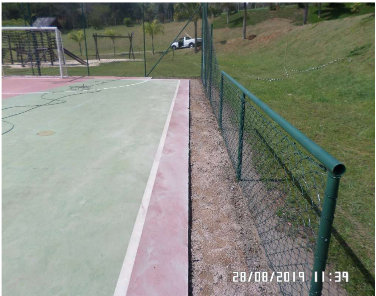
Quadra Poliesportiva - Reparo em trecho danificado
