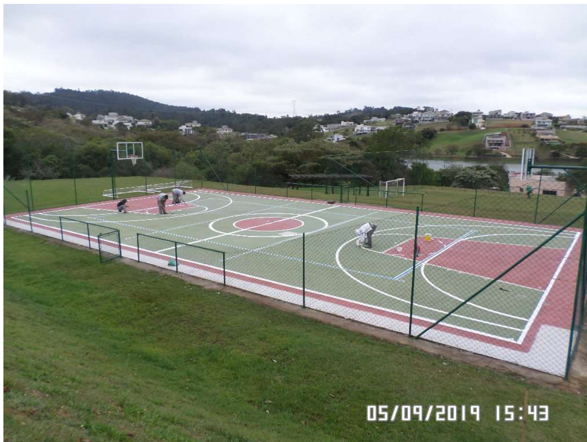
Quadra Poliesportiva - Durante a pintura
