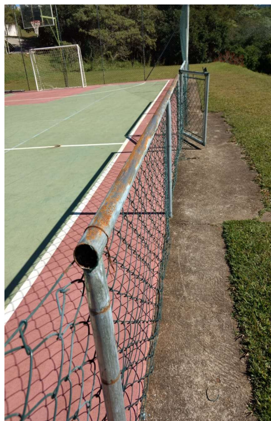
Figuras 1 – Raspagem de material e limpeza de pontos com ferrugem.
