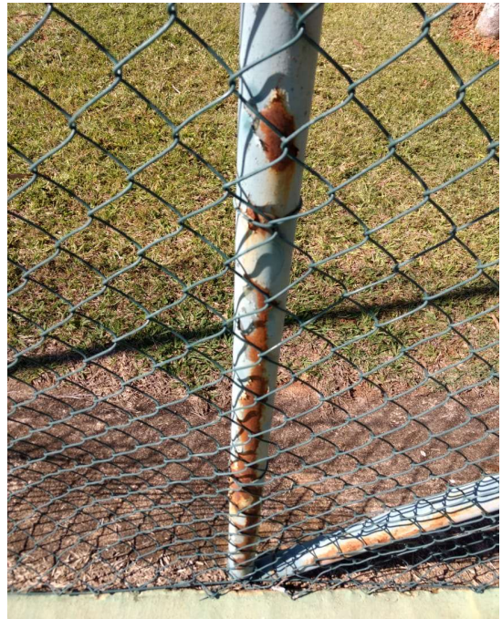
Proteção (tinta) das estruturas danificadas pela ação de intempéries
