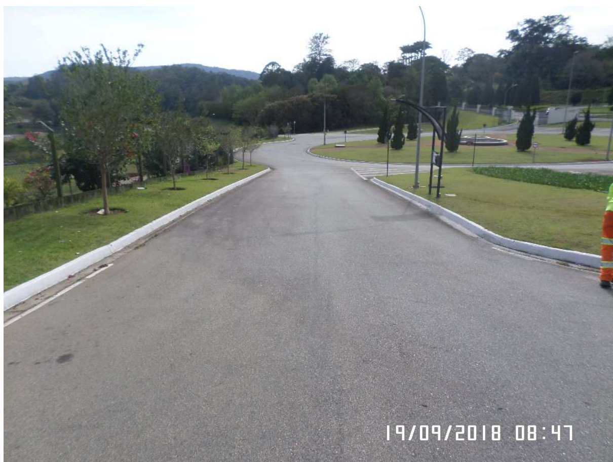
Avenida Vicenza - Com Totem para visitantes e sem sinalização (antes)
