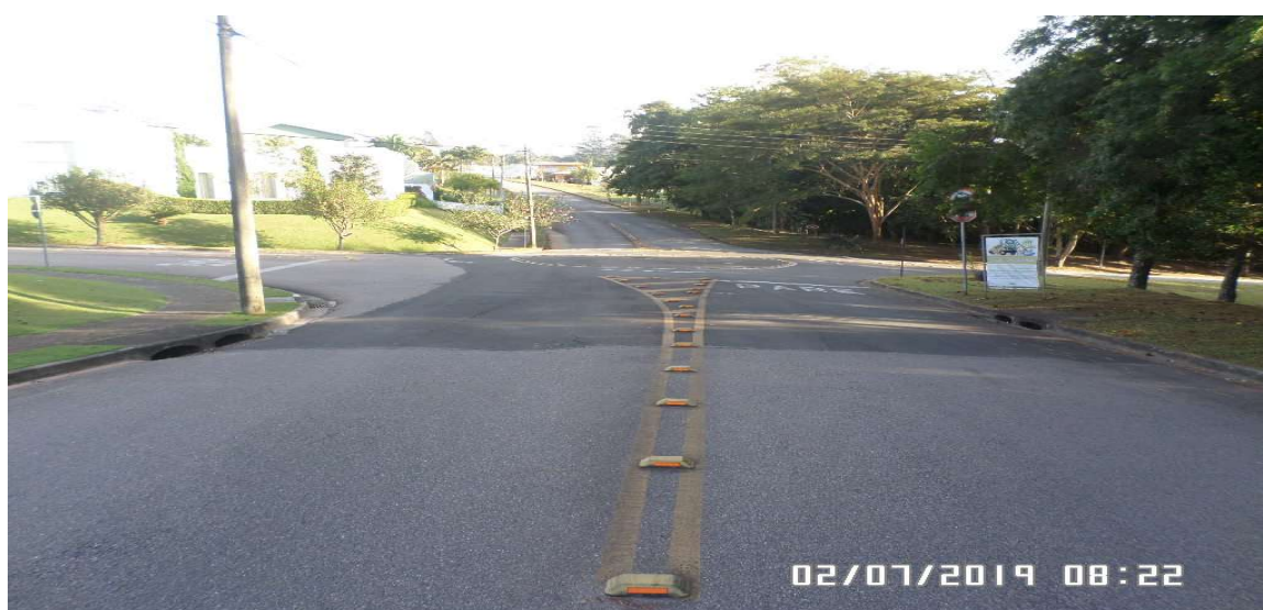
Rua Asti - Sinalização deteriorada pelo decurso do tempo
