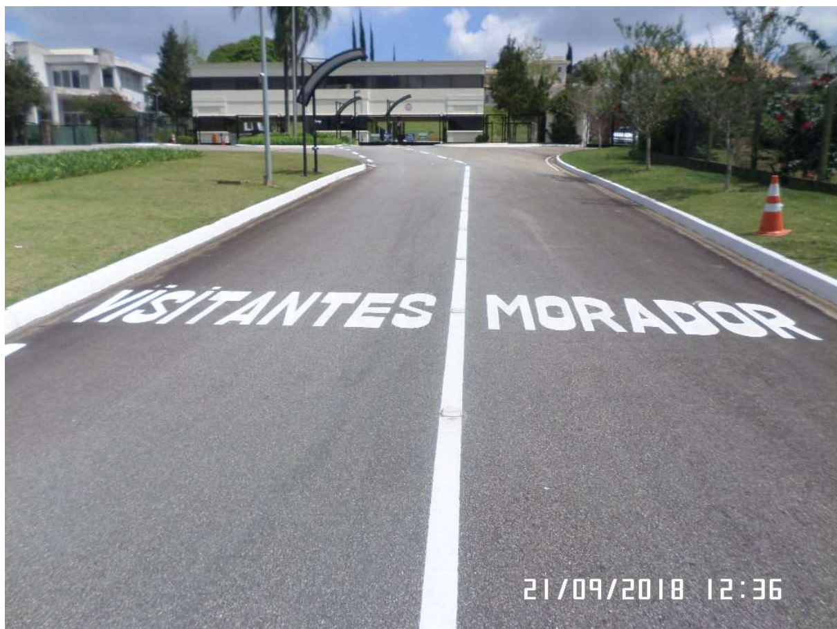
Avenida Vicenza - Com Totem e sinalização horizontal (depois)
