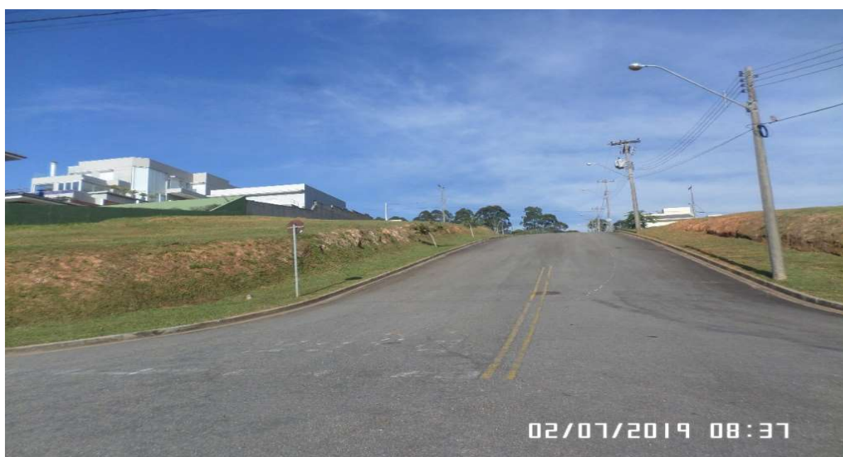
Rua Bologna - Sinalização deteriorada pelo decurso do tempo
