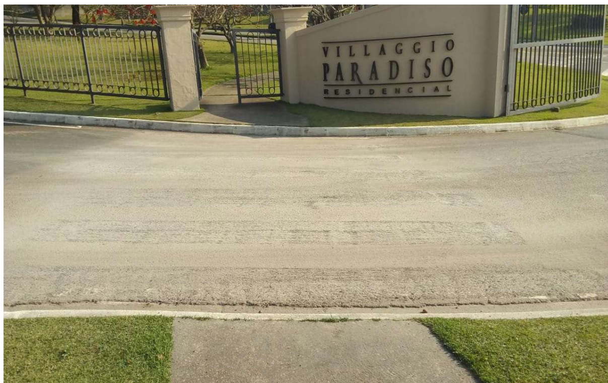
Fresagem de faixa de pedestres anteriormente existente
