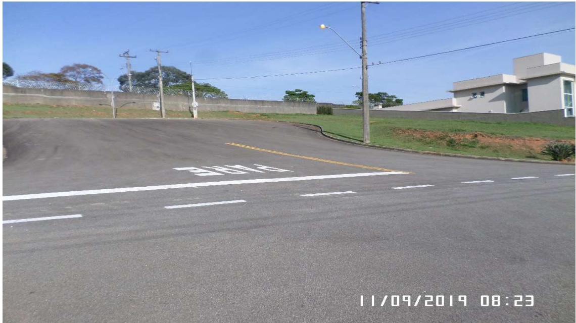
Rua Bologna - Com sinalização
