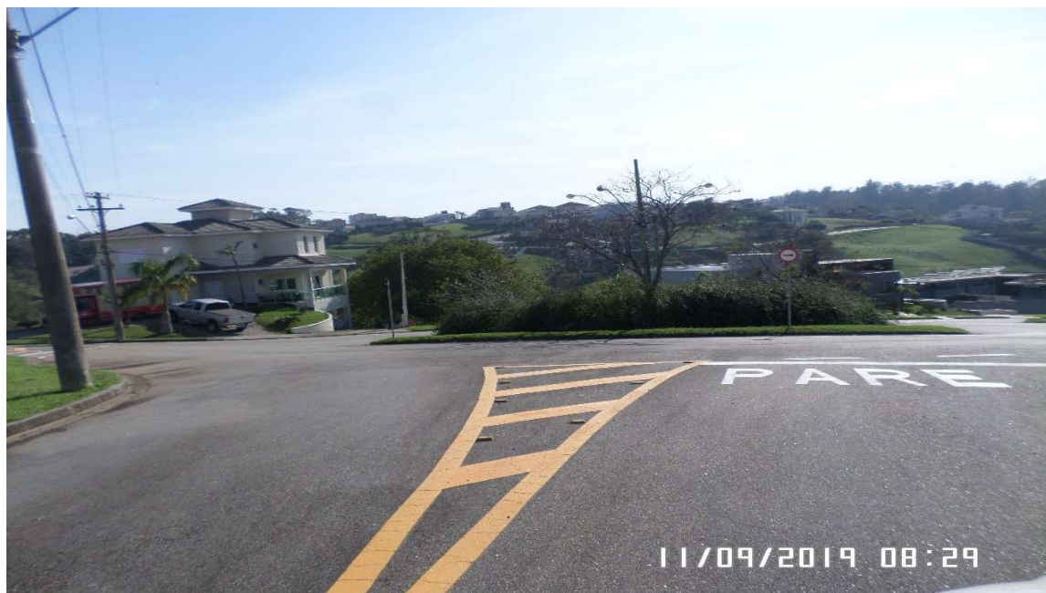
Rotatória das ruas: Ferrara e Mantova - Com sinalização
