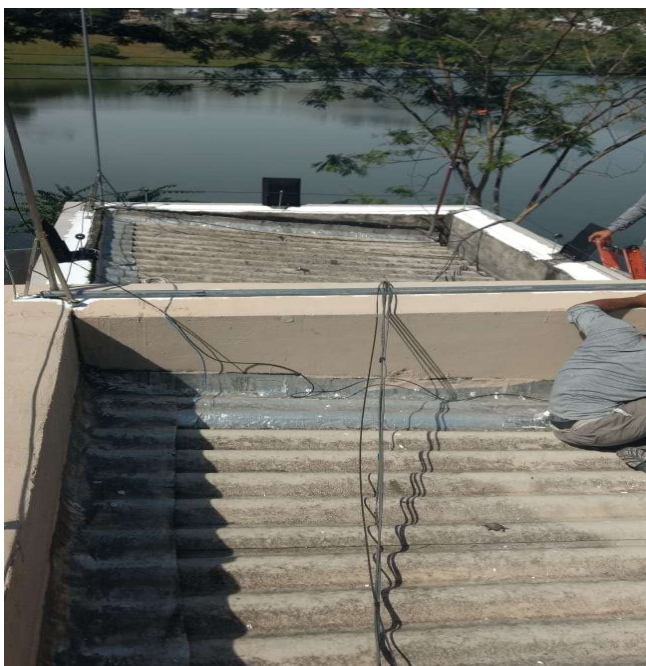
Realização da pintura
