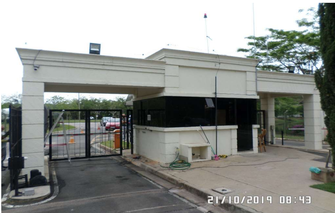
Fachada da portaria antes da reforma
