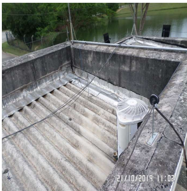
Telhado com pontos de infiltrações, fissuras e sem vedação.
