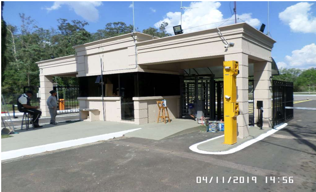
Realização da pintura da fachada e passeio da portaria de serviços
