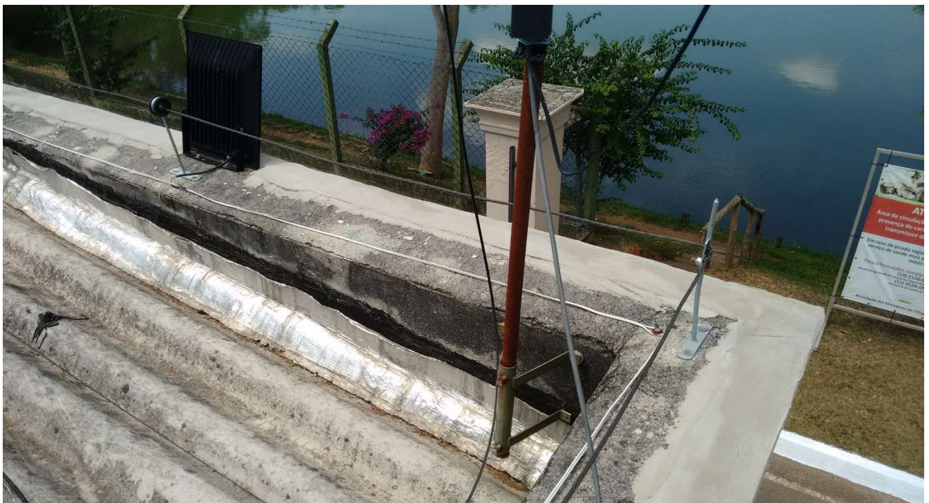
Realização de limpeza e impermeabilização.
