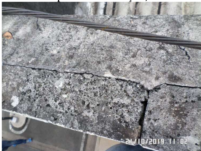
Telhado com pontos de infiltrações, fissuras e sem vedação.
