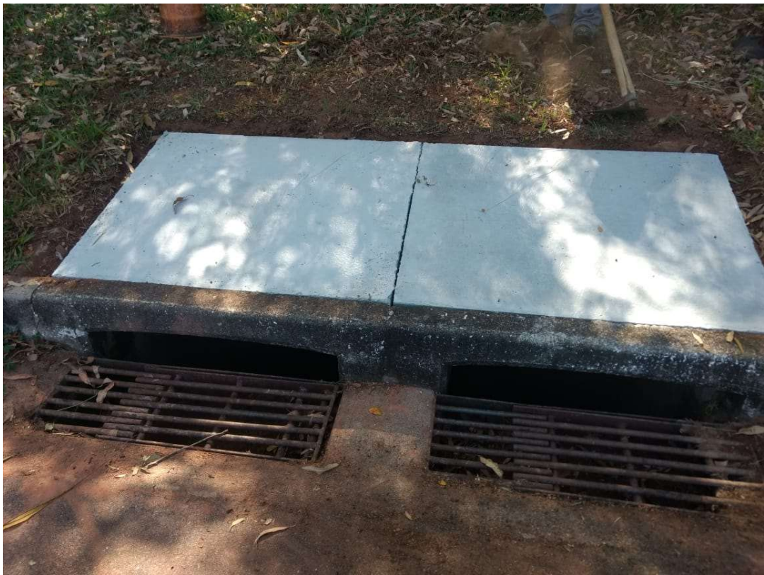
Tampa de boca de lobo substituída.
