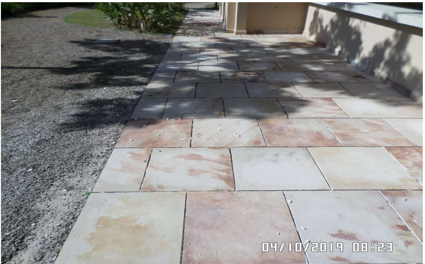
Retirada dos rejuntas.
