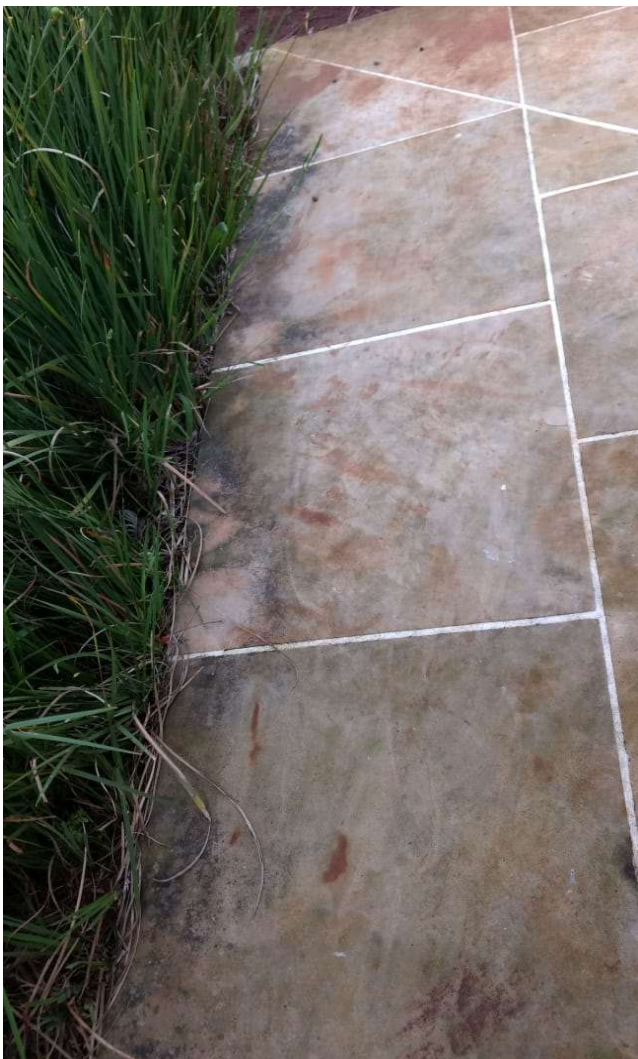
Pedras com mofo e com rejuntas danificadas
