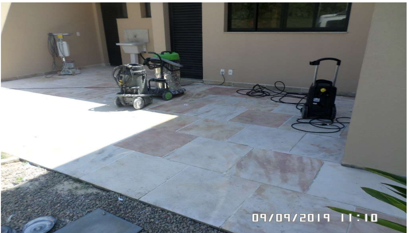
Retirada de fungos
