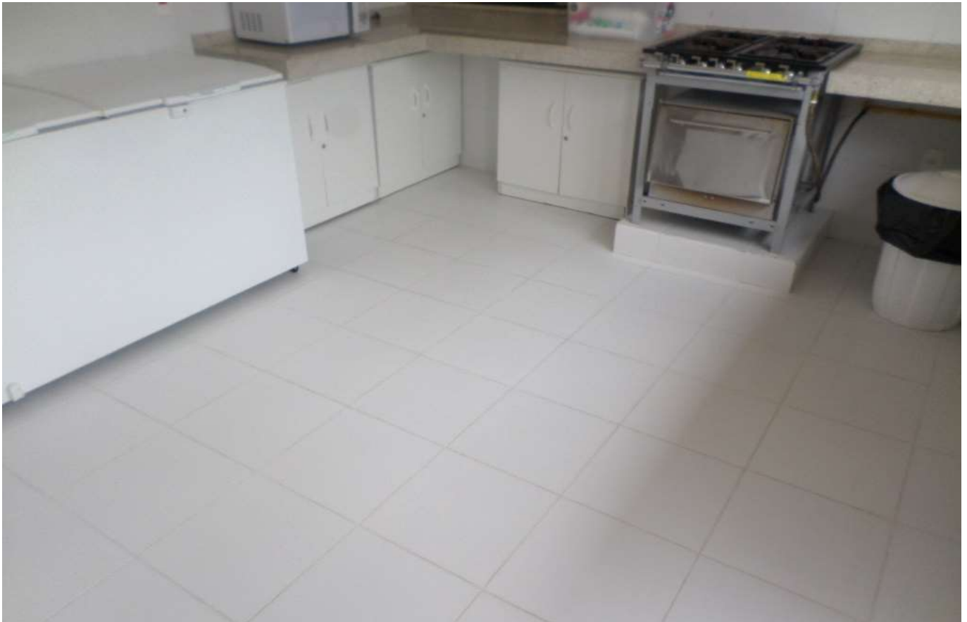
Piso da cozinha após processo de limpeza
