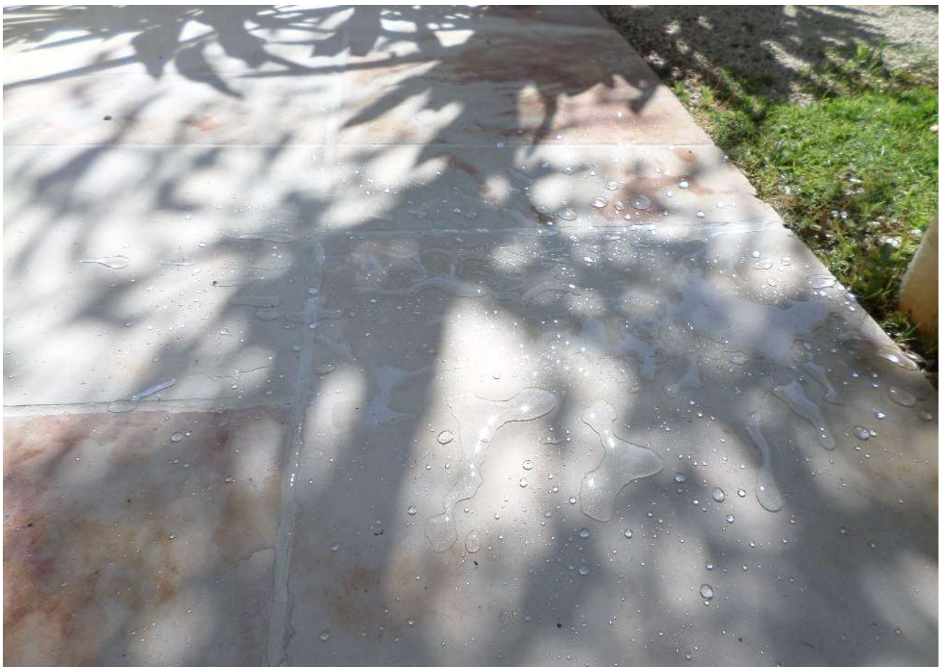
Teste de impermeabilidade
