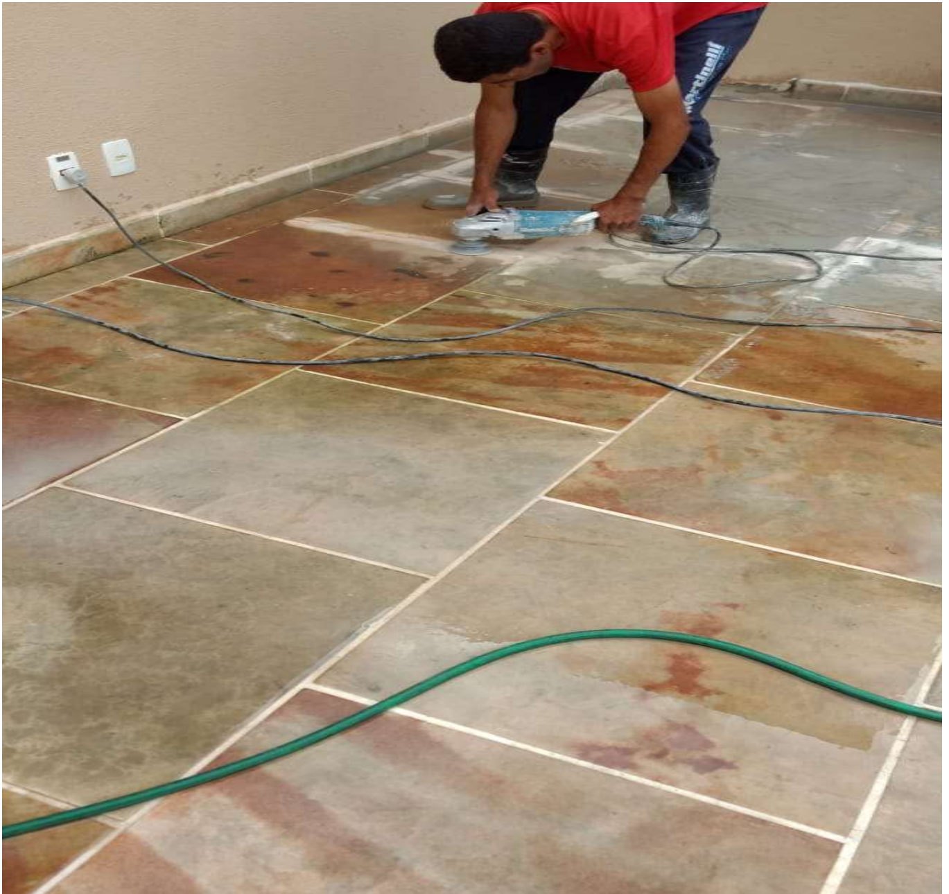
Levigamento das juntas e lapidação das pedras.
