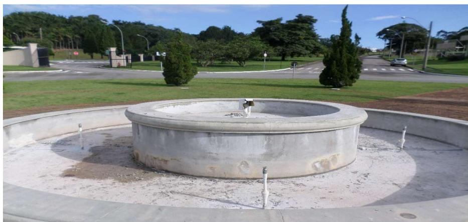
**Pontos de infiltração ascendente e eflorescência**
