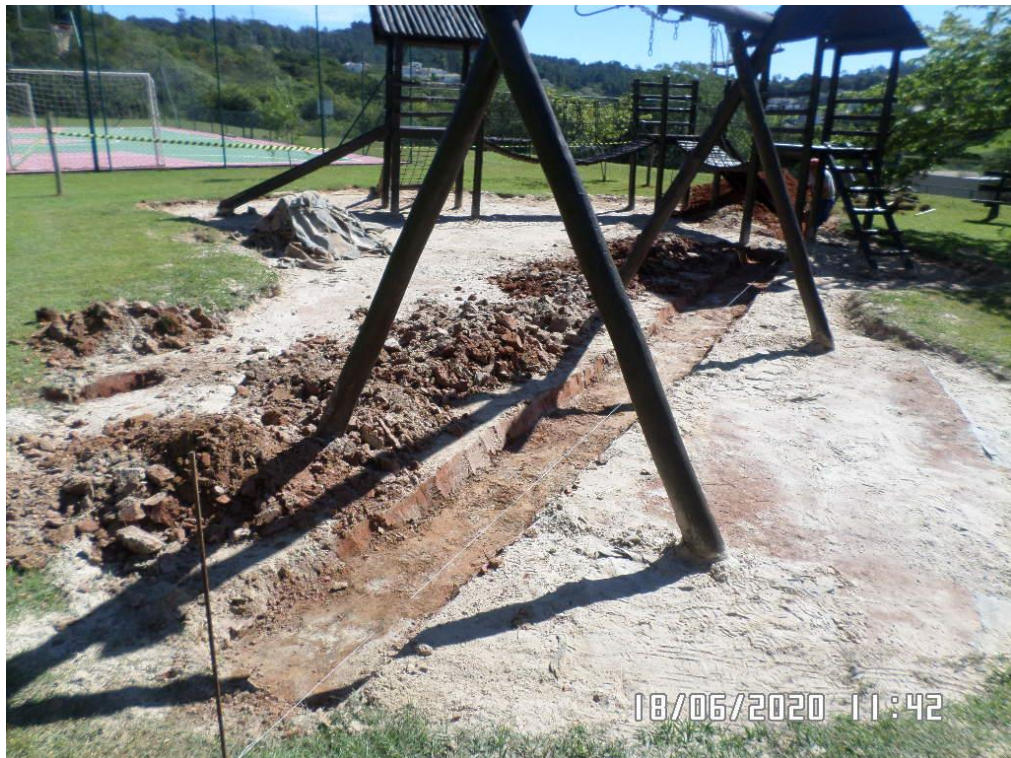
Realização do corte do solo para execução das canaletas de drenagem
