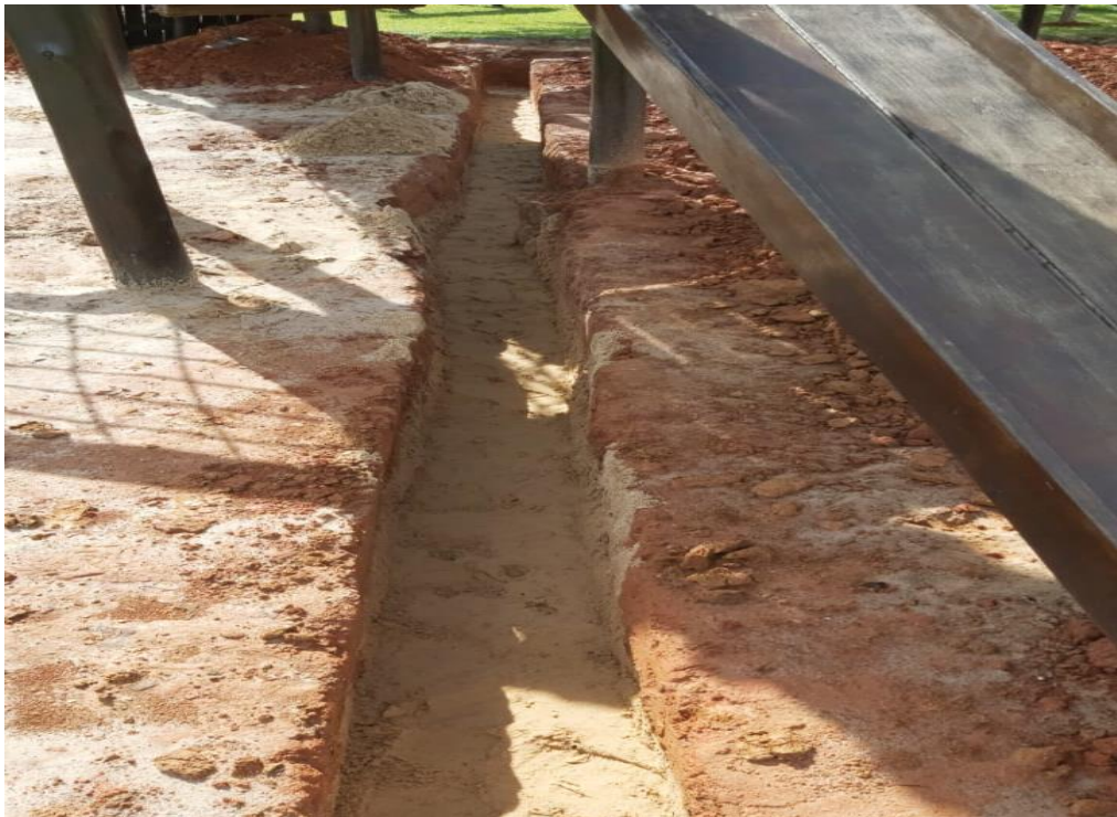
Aplicação de uma camada de areia para regularização
