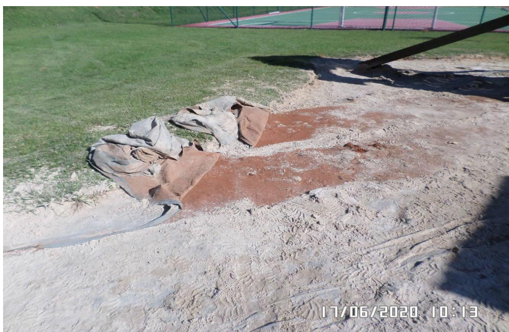
Detalhe da retirada da areia e manta geotêxtil
