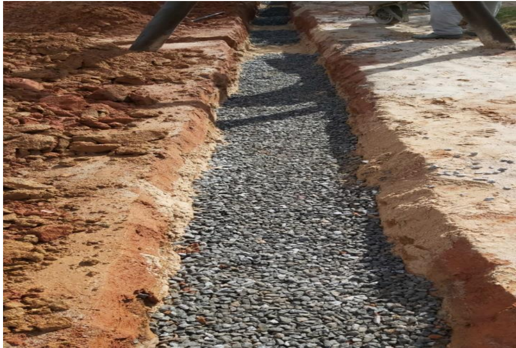
Aplicação de brita 1
