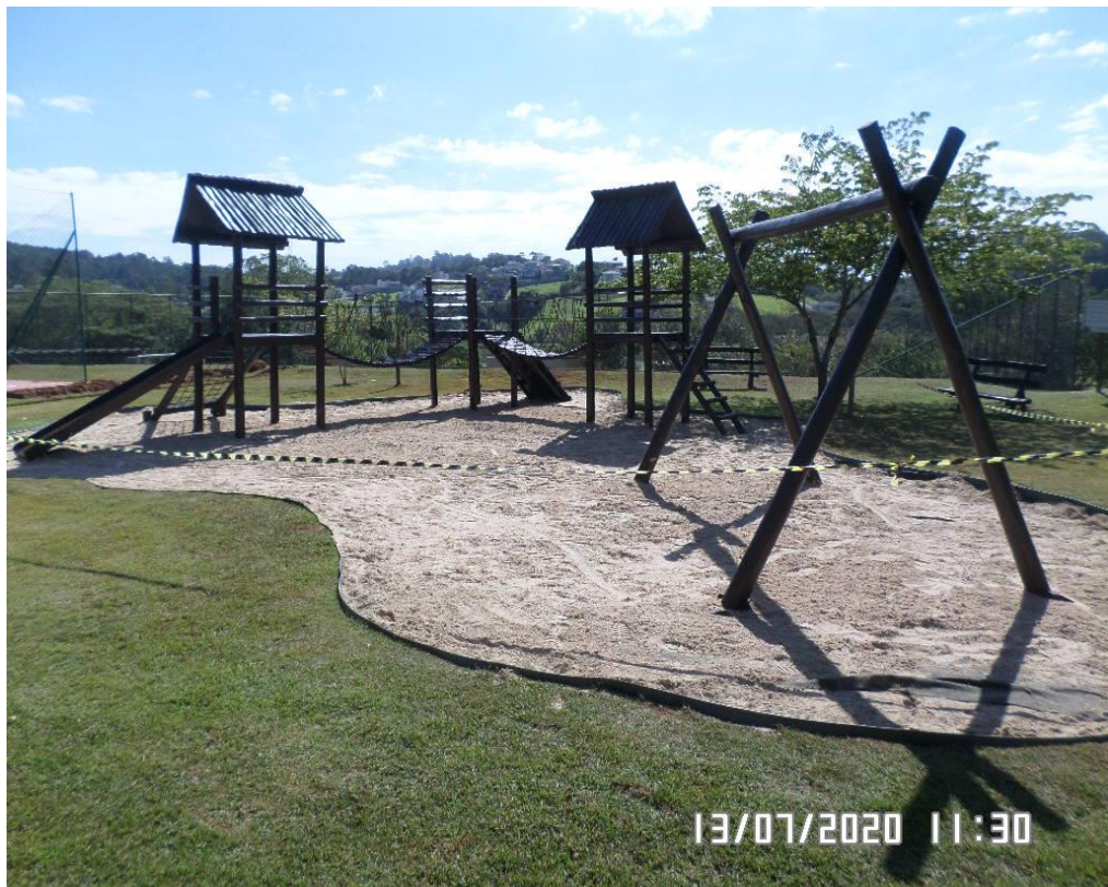
Implantação da 1ª camada de areia - 7m³
