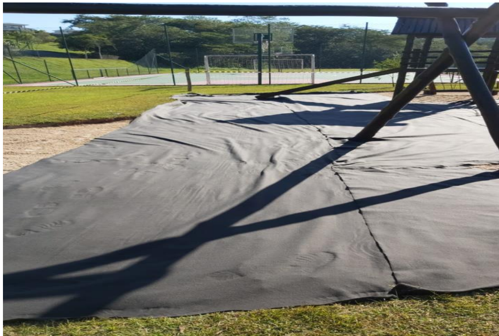
Implantação de manta geotêxtil
