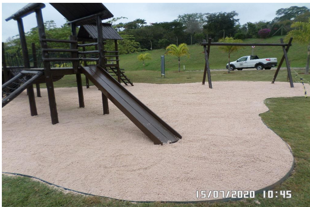
Implantação da 2ª camada de areia - 5m³
