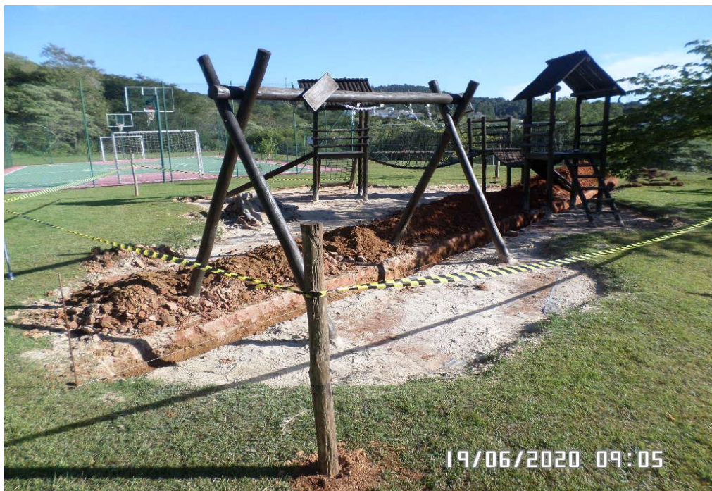
Execução das canaletas para drenagem
