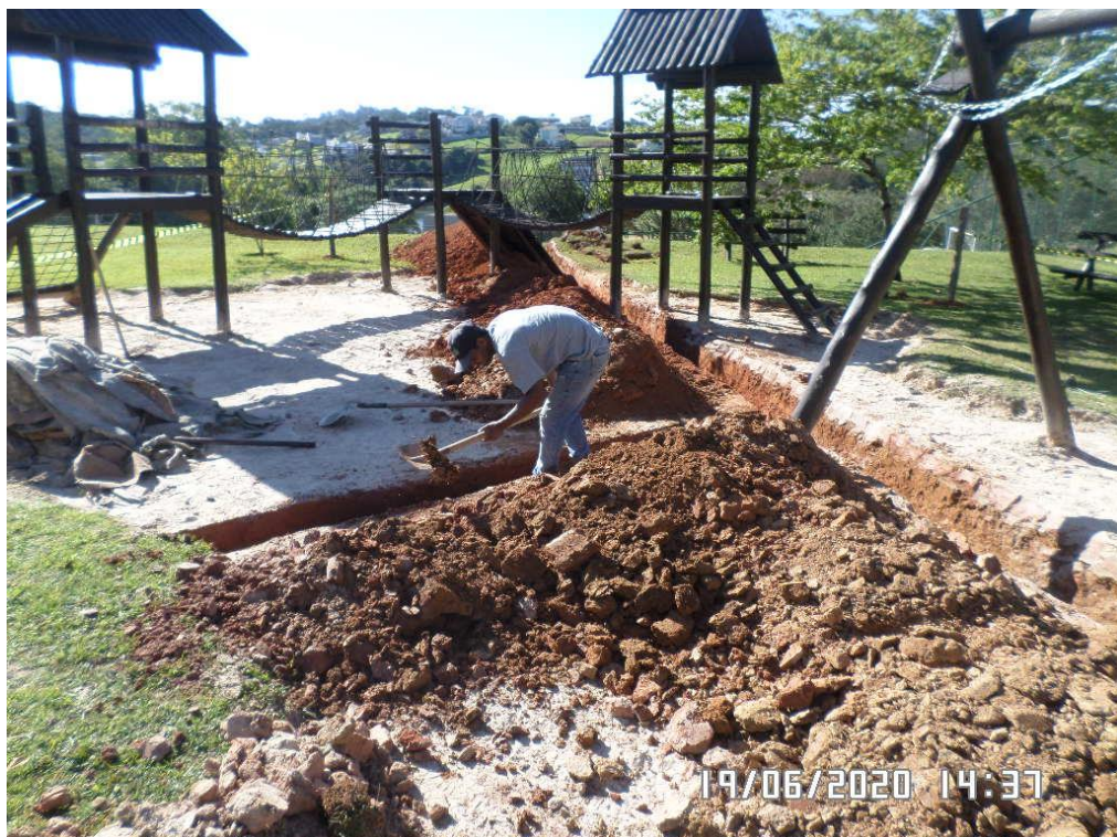
Execução das canaletas para drenagem
