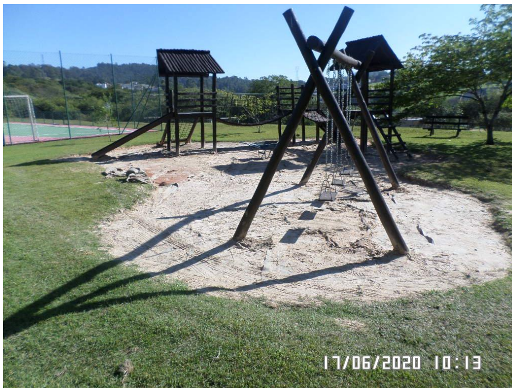
Retirada da areia e manta geotêxtil
