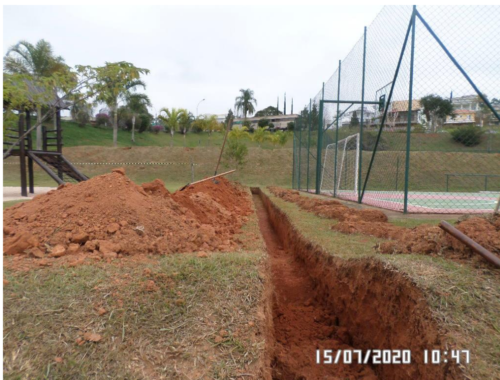
Execução da canaleta de drenagem lateral
