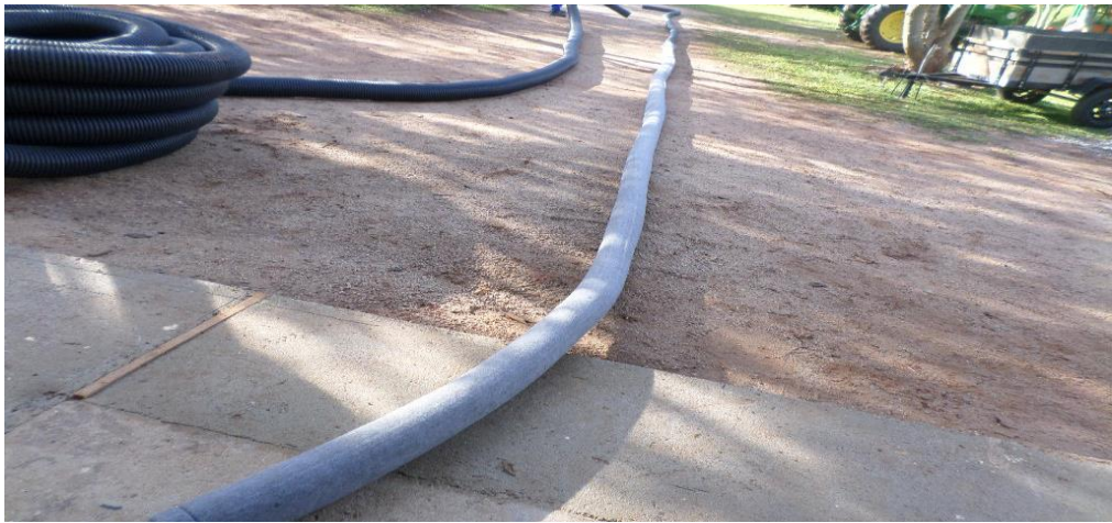
Revestimento dos tubos de dreno com camisa de manta geotêxtil
