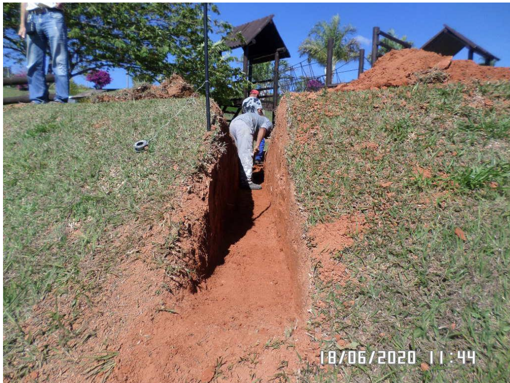
Execução das canaletas para drenagem
