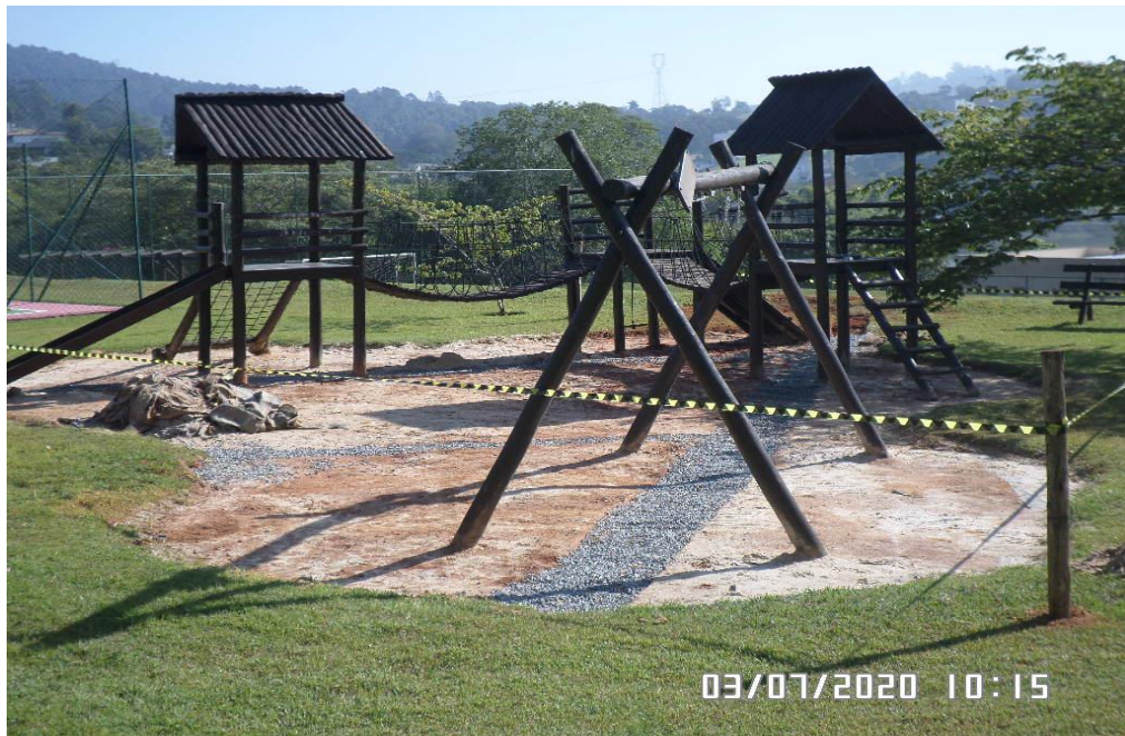
Drenos executados, cobertos por brita 1
