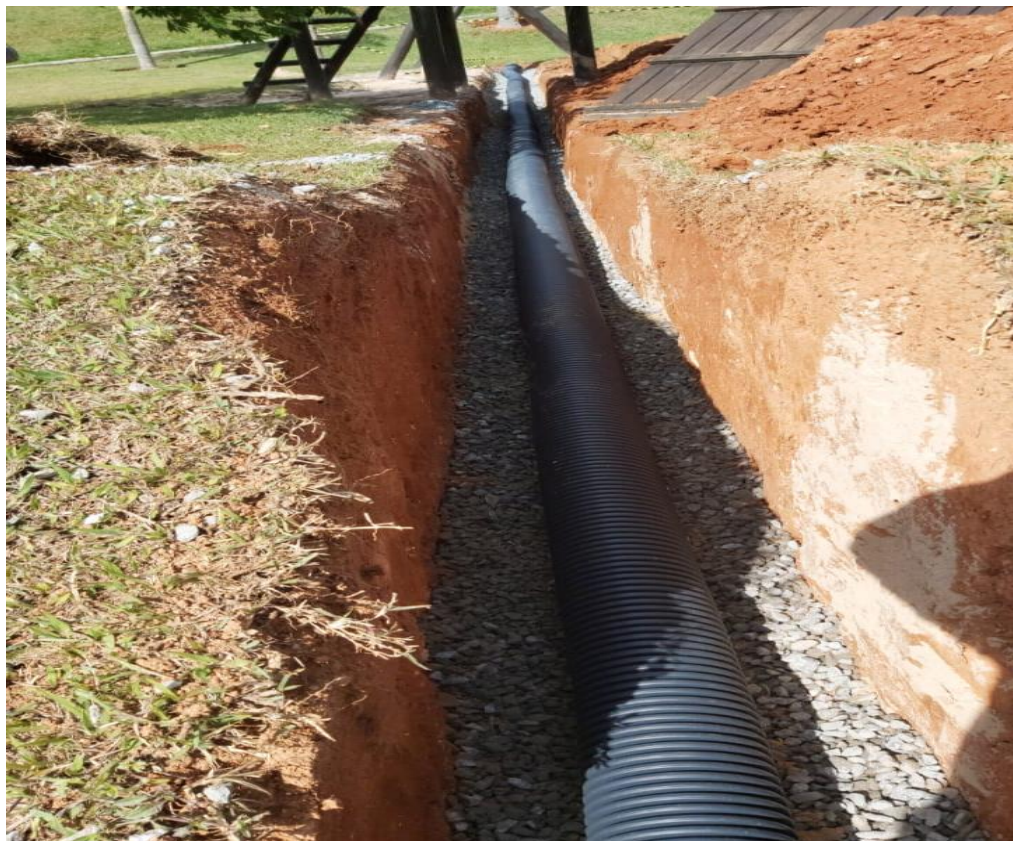
Execução de tubos de dreno
